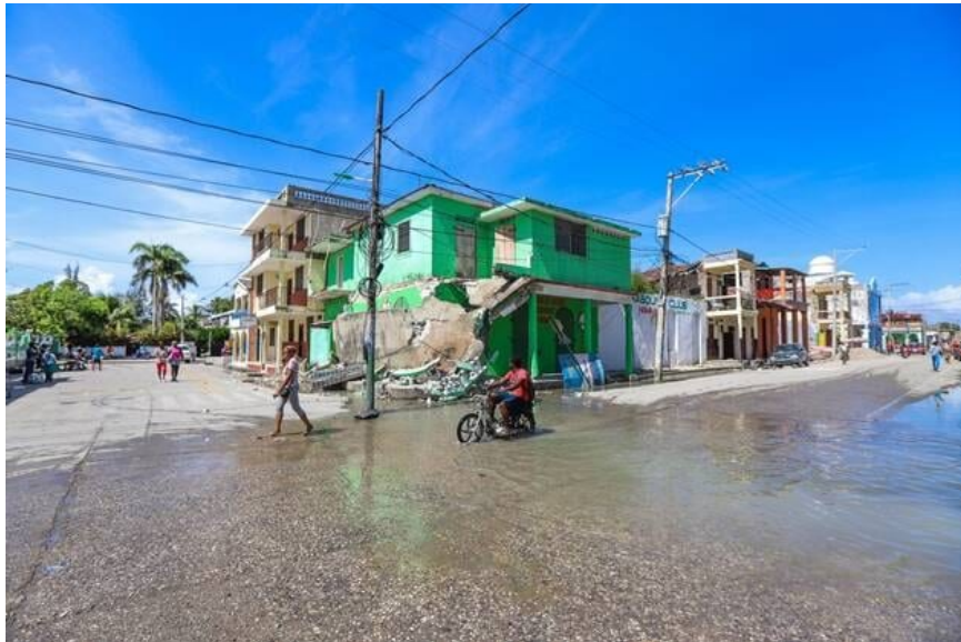
Rue inondée aux Cayes
